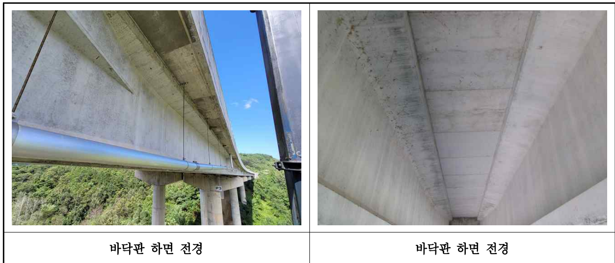
【사진 12.3.2】 바닥판하면 전경
