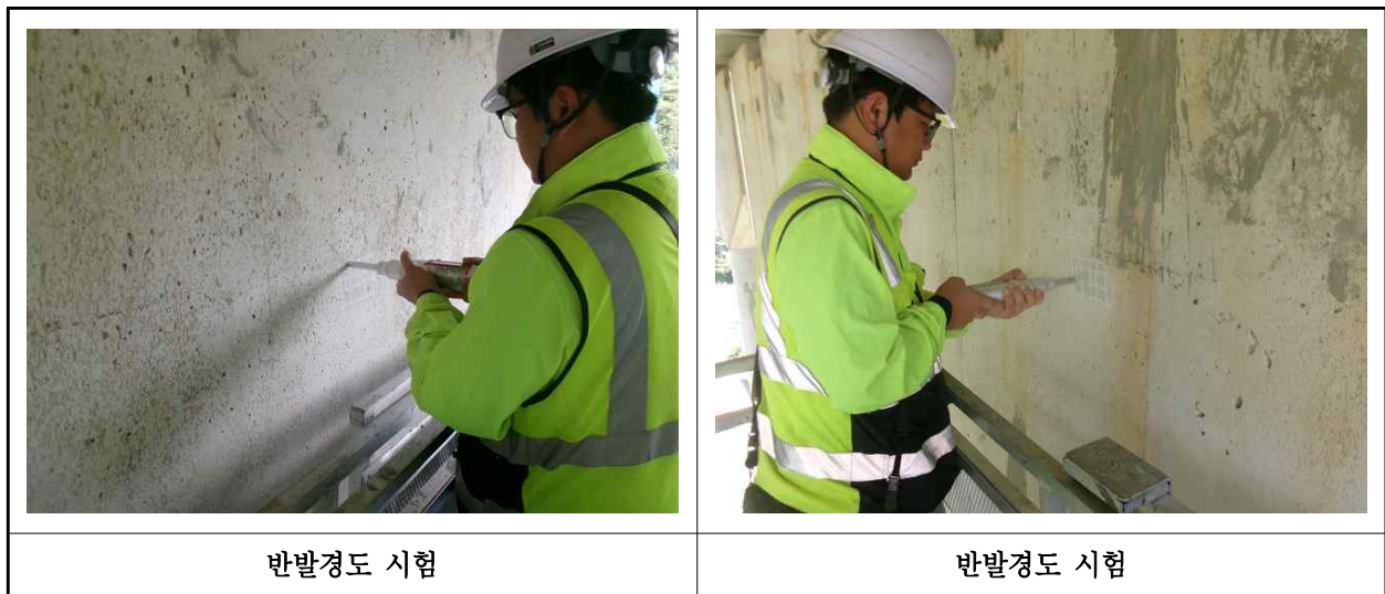
【사진 12.4.2】 반발경도시험 현장사진
