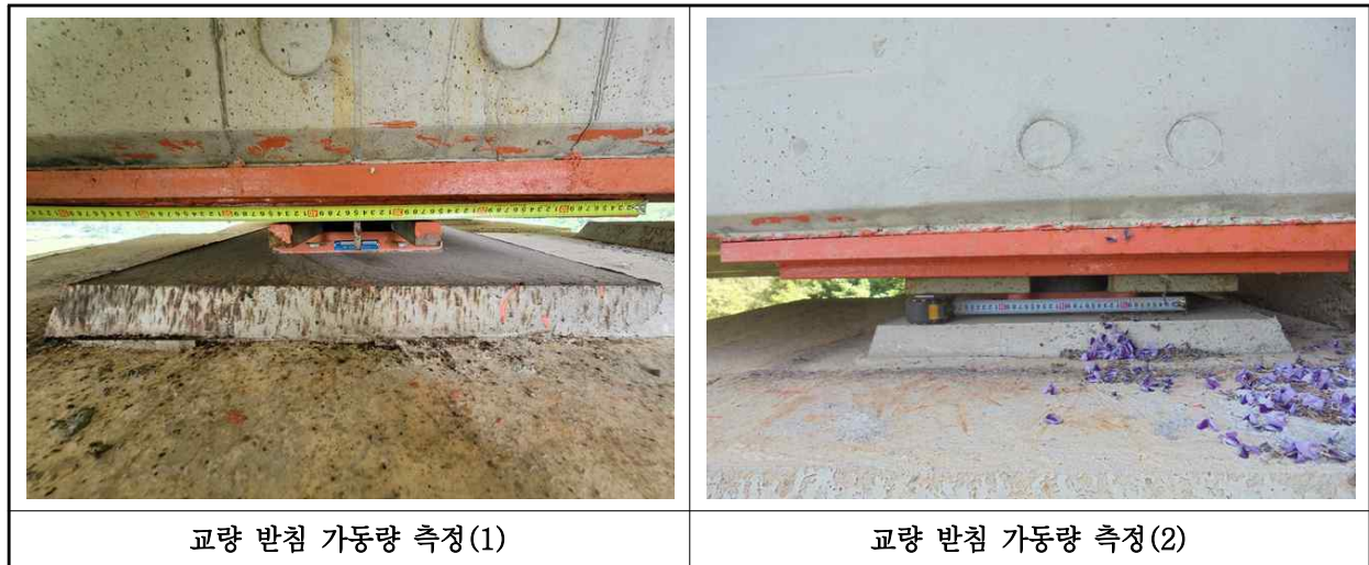
【사진 12.3.41】 교량받침 이동량 측정
