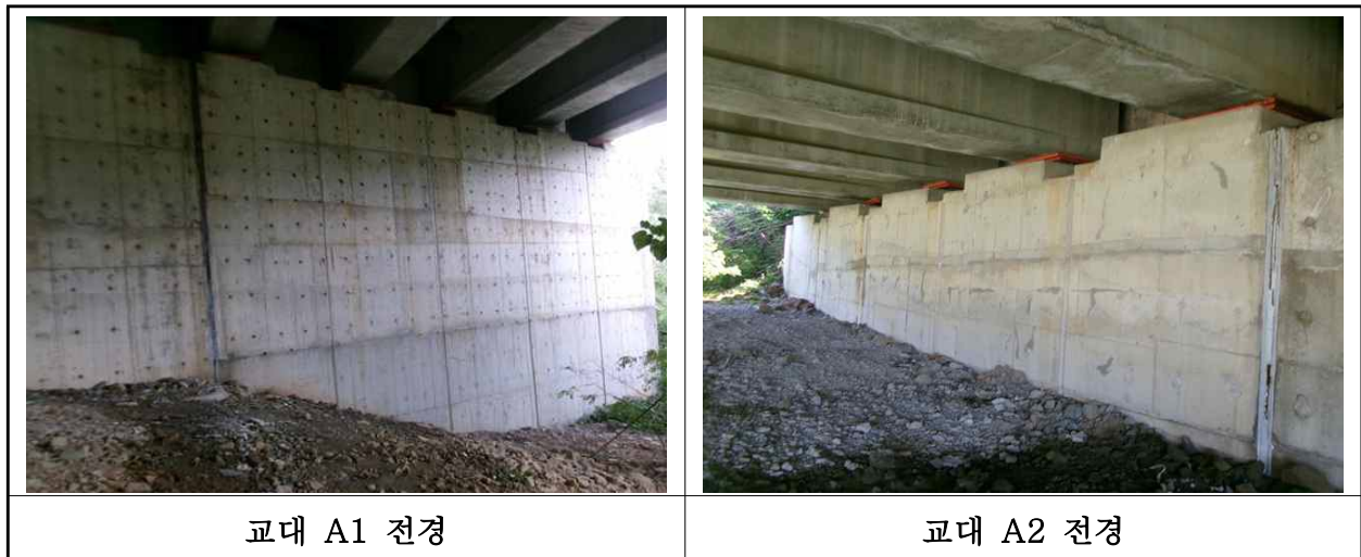
【사진 12.3.8】 교대 전경
