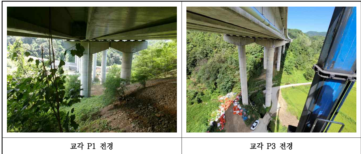
【사진 12.3.10】 교각 전경
