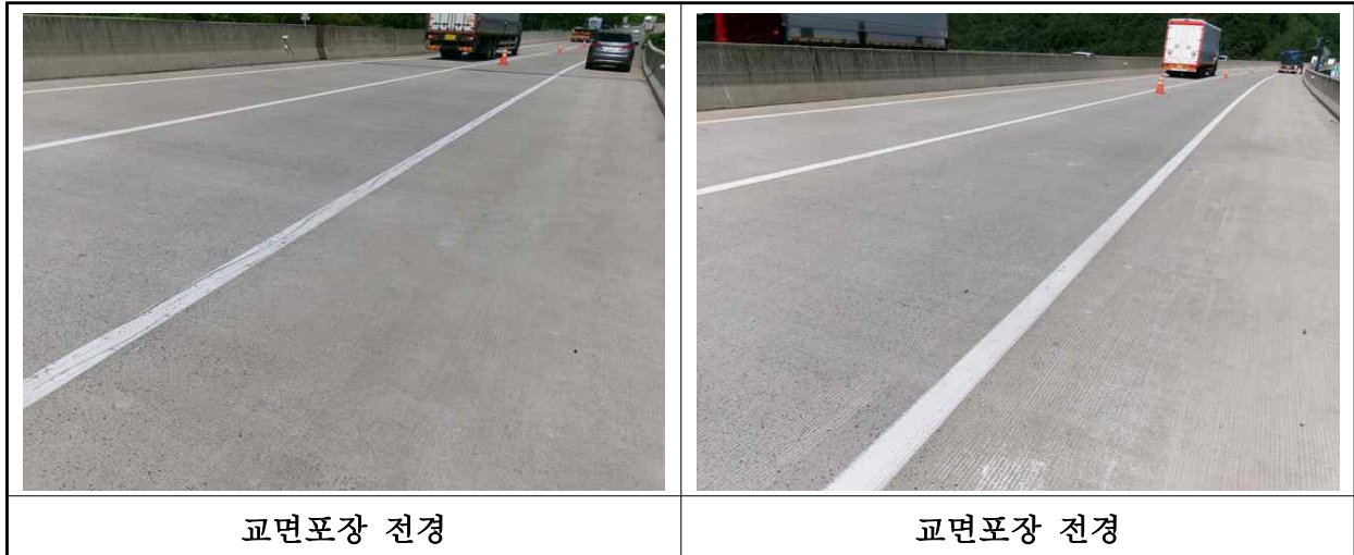
【사진 12.3.20】 교면포장 전경
