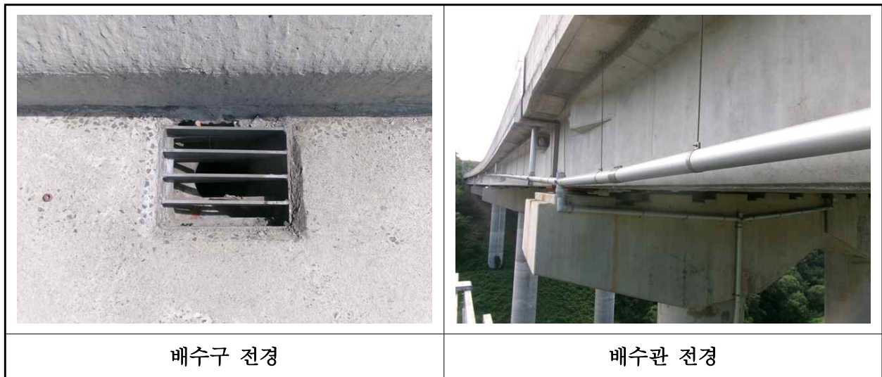
【사진 12.3.22】 배수시설 전경
