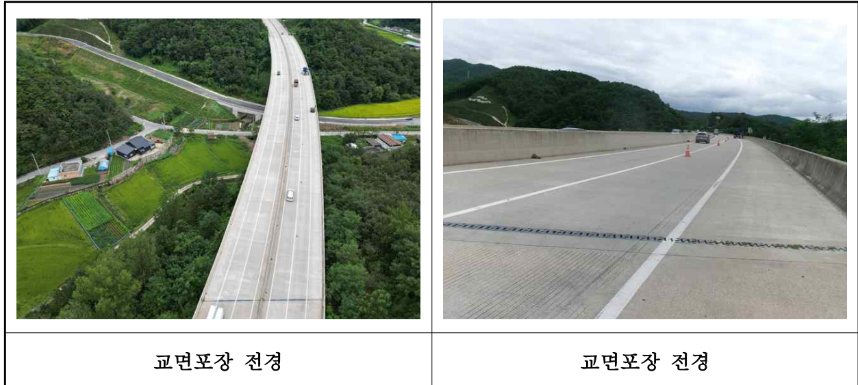
【사진 12.3.45】 교면포장 전경
