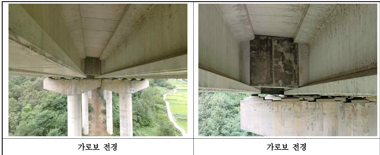
【사진 12.3.31】 가로보 전경
