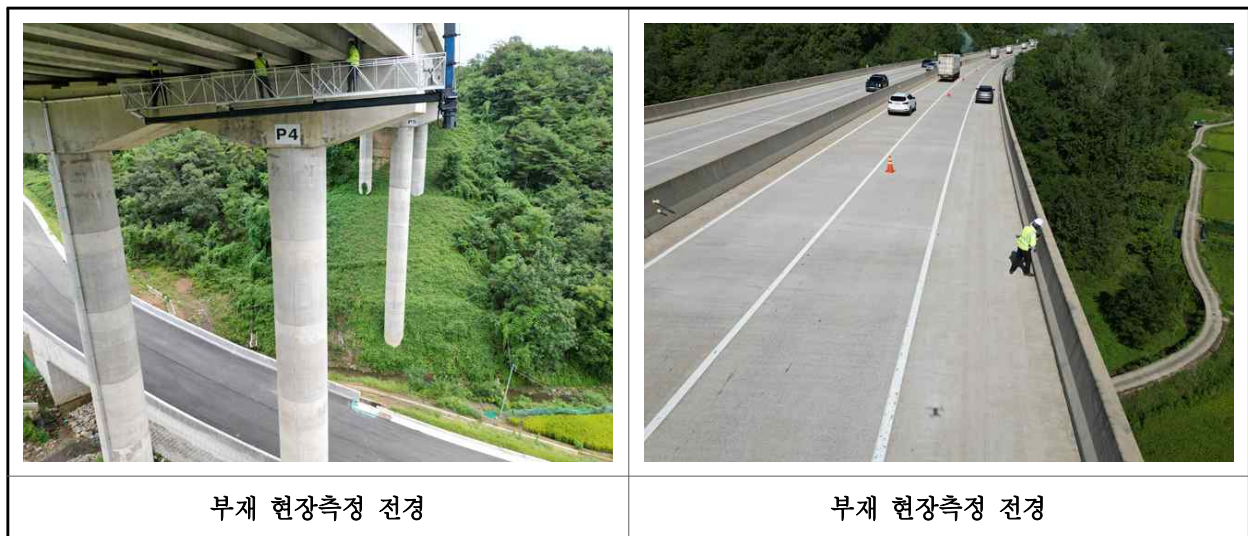
【사진 12.2.1】 부재 현장측정 전경
