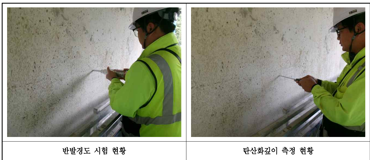
【사진 12.4.1】 콘크리트 내구성조사 현황
