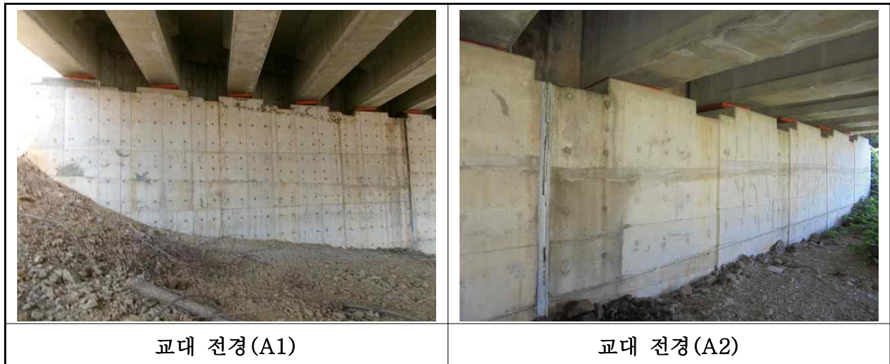
【사진 12.3.33】 교대 전경
