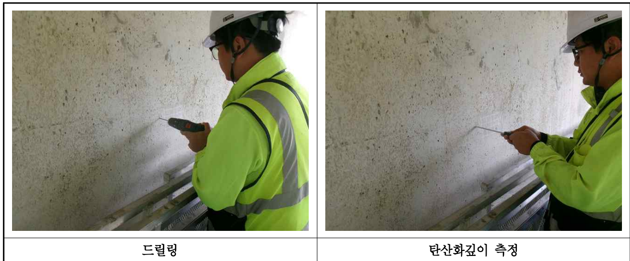
【사진 12.4.3】 탄산화 깊이 측정 현장사진
