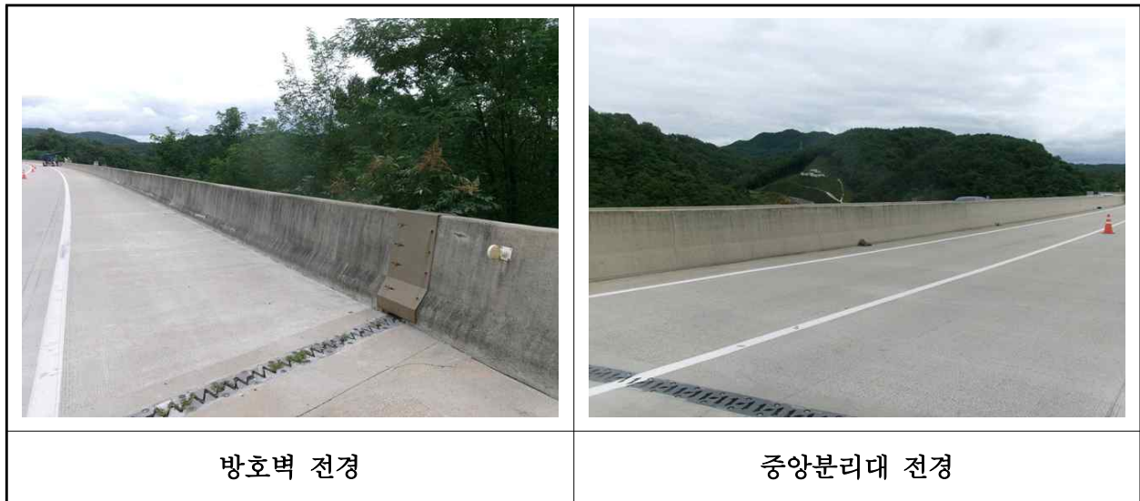
【사진 12.3.49】 방호벽 및 중앙분리대 전경
