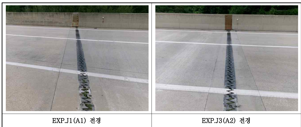
【사진 12.3.42】 신축이음장치 전경
