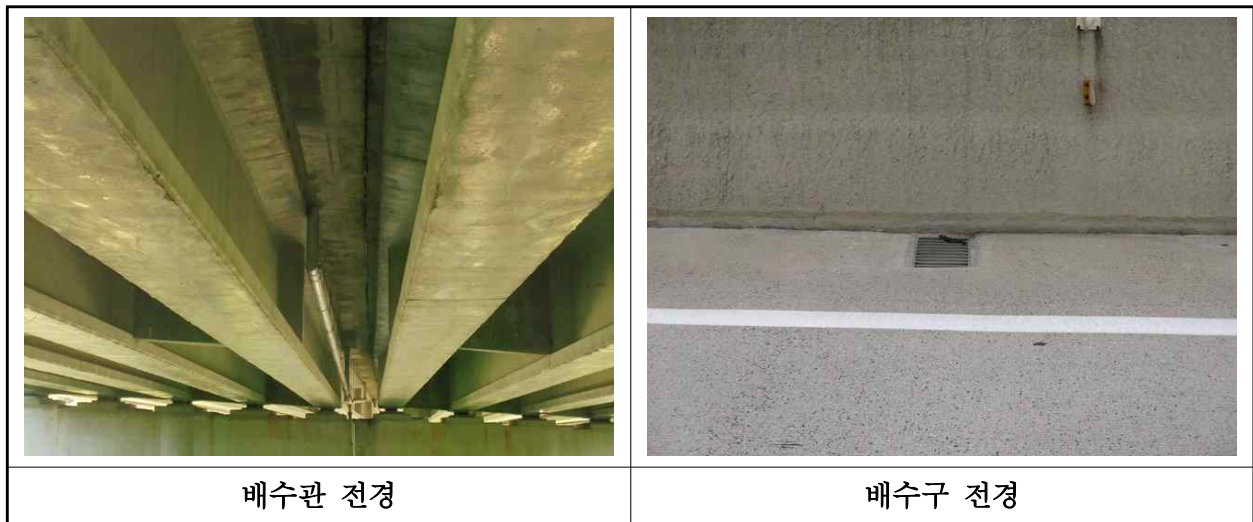
【사진 12.3.47】 배수시설 전경
