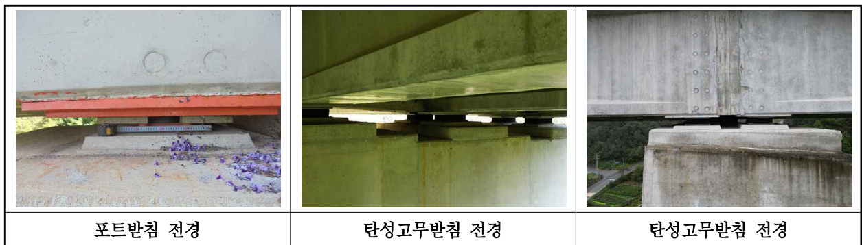
【사진 12.3.38】 교량받침 전경
