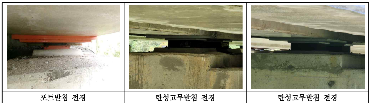
【사진 12.3.13】 교량받침 전경
