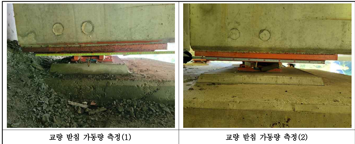
【사진 12.3.16】 교량받침 이동량 측정
