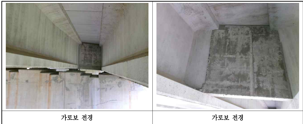
【사진 12.3.6】 가로보 전경
