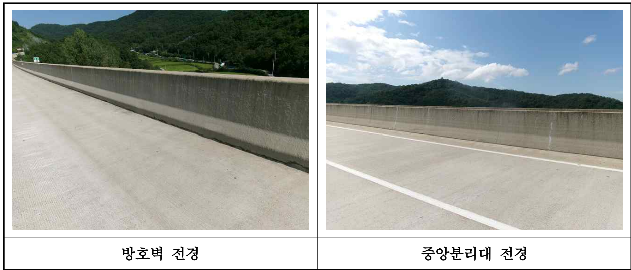
【사진 12.3.24】 방호벽 및 중앙분리대 전경
